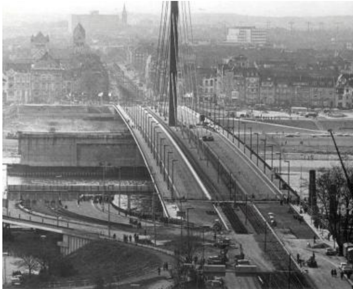
Neubau der Oberkasseler Brücke
